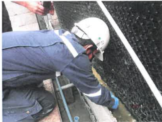
รูปที่ 3-3 การติดตามตรวจสอบคุณภาพน้ำที่เข้าหอผึ่งเย็น บริเวณอ่างรองรับ (Cooling Tower)
